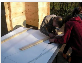
Projektarbeit „Bau eines Spielhäuschens“
